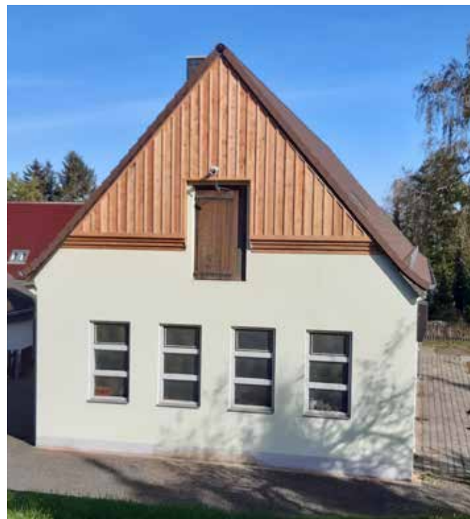
Forstgarage an der Leipauer Straße in Olbersdorf
